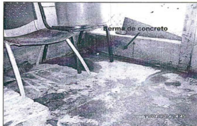
Fotografía N° 2. Se ha construido una berma de concreto de aprox. 25 cm de alto, para la contención y colección de las aguas de lavado en el Punto de Acopio de Residuos Sólidos.
