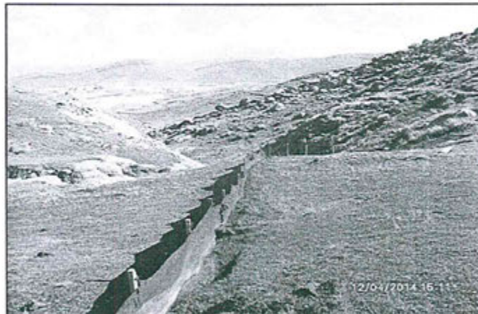
Fotografía N° 7. Vista de la instalación de Silt Fence, para la retención de sólidos arrastrados por la lluvia o por las infiltraciones de la zona.
