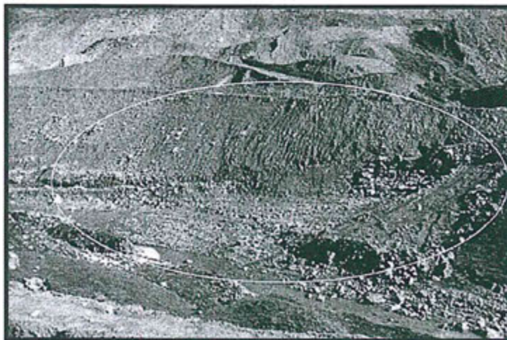
Fotografía N° 34. Hallazgo N° 3. Otra vista de la parte baja de la zona ingreso a los trabajos que se están realizando para la chancadora, donde se observa que no existen los controles para evitar el arrastre de material al río Ferrobamba, cabe señalar que se observan rastros del arrastre del material.
