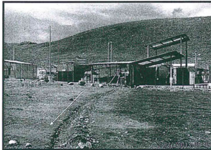
Fotografía N° 17: Hallazgo N° 1. Parte del Canal que conduce las aguas producto de la limpieza del almacén (efluente) de residuos sólidos del campamento Charcacocha hacia la quebrada adyacente al campamento.
