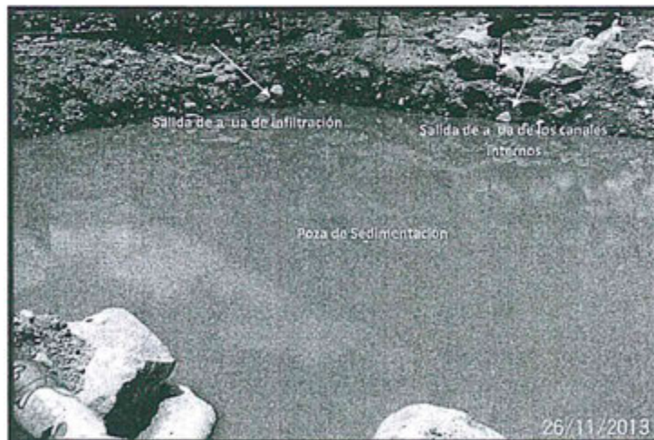
Fotografía N° 27: Hallazgo N° 2. Vista del ingreso de las aguas de infiltración y las aguas que se colectan con los canales internos de dicha planta a la primera poza de sedimentación, cabe señalar que a la fecha de la supervisión no se observó ingreso de aguas de infiltración y aguas de los canales internos.
