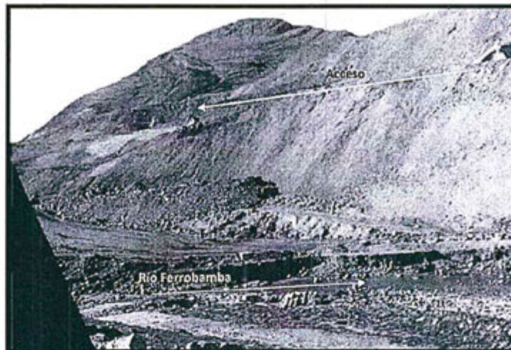
Fotografía N° 40. Vista del acceso hacia la zona donde se está realizando trabajos de acondicionamiento del terreno para la construcción de la Chancadora y también sirve de acceso para la zona del tajo Ferrobamba. En la foto se observa también en la parte baja del acceso el río Ferrobamba, zona donde se identificó el Hallazgo N° 3.
