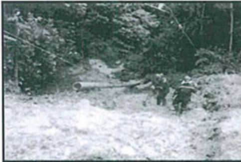
Fotografía N° 18: Trabajos de ejecución en las laderas de la plataforma.
