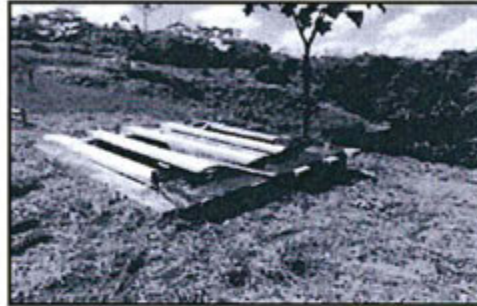
Fotografía N° 31: Se construyó nueva poza API
