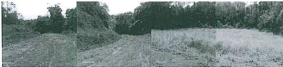
Fotografía N° 2: Trabajos concluidos de control de erosión en el camino de ingreso a la plataforma 1301.
