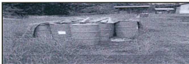
Fotografía N° 50: Vista de un punto de almacenamiento de lubricantes ubicado en un área inadecuada (Yacimiento Chambirá). Se observa que el área no se encuentra impermeabilizada y tampoco cuenta con sistema de doble contención.
