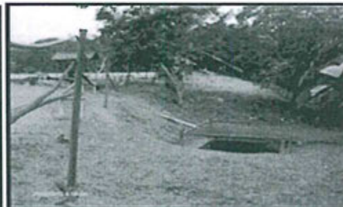
Fotografía N° 23: Obras de control de erosión de la plataforma 1107.
