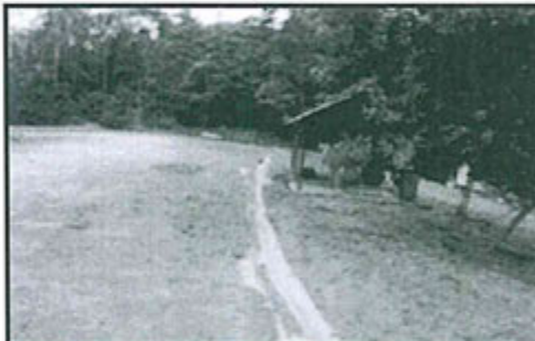
Fotografía N° 20: Canaletas de desvío de agua fluvial.
