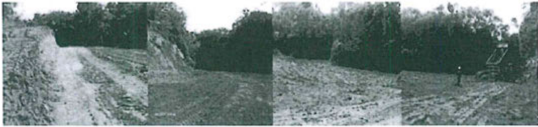
Fotografía N° 1: Trabajos de ejecución de control de erosión en el camino de ingreso a la Plataforma 1301.
