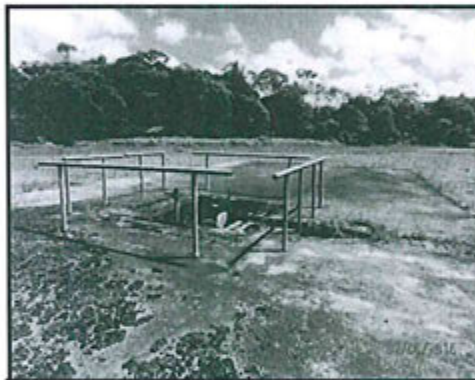
Fotografía N° 27: Plataforma nivelada y desbrozada.
