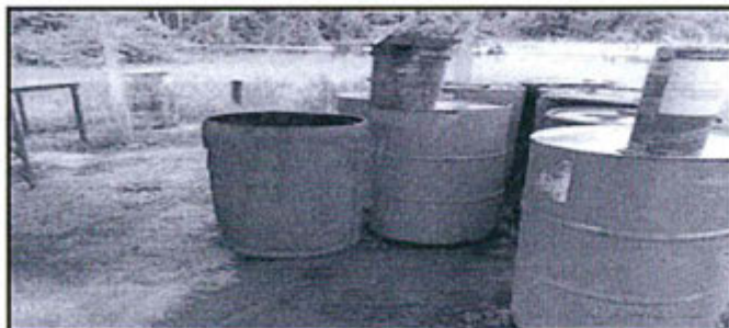
Fotografía N° 49: Vista del centro de almacenamiento de lubricantes y químicos de Chambirá. Se observa que dicha área no cuenta con sistemas de doble contención.
