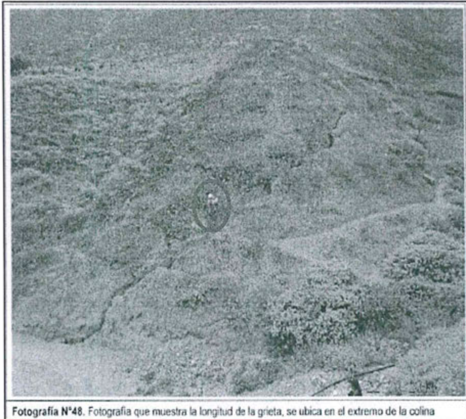
Fotografía N° 48: toma panorámica que muestra la longitud de la grieta en el extremo de la colina en el acceso del sector Gayayniyoc. En el círculo el Supervisor.
