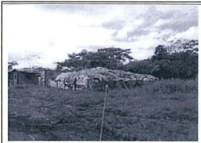
Foto N° 16: Muestra el centro de acopio de residuos peligrosos que no reúne las condiciones adecuadas para el almacenamiento temporal, un área de 100 m 2 aproximadamente, sin techo a granel, sin letreros.
