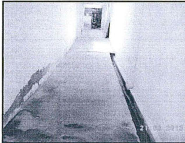
Foto N° 14. Parte inicial, de una canaleta externa a la sala de proceso. (Limpieza de planta)
