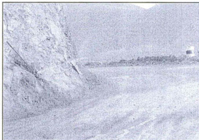
Fotografía N° 34 del Informe de Supervisión.- Riego por aspersión mediante tuberías instaladas en ciertos tramos de la vía de acceso hacia las diferentes secciones de la unidad minera.
