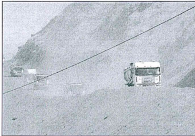
Fotografía N° 58 del Informe de Supervisión.- Se observó en las vías de acceso hacia la Unidad Minera "Cerro Lindo" levantamiento de polvo al paso de los vehículos que transportan concentrado y otros ya que el sistema de riego actual no es suficiente.
