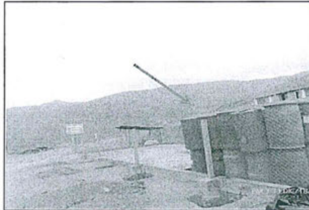
Fotografía N° 69 del Informe de Supervisión. - Otra vista del depósito de almacenamiento temporal de residuos peligrosos sin techo de protección, donde los residuos se encuentran a la intemperie y sin letreros de identificación y de peligrosidad.
