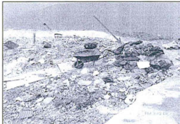
Fotografía N° 71 del Informe de Supervisión.- Otra vista del relleno sanitario donde se observa los residuos sólidos (botellas de plástico, latas, bolsas con restos de comida, etc.) expuestos a la intemperie sin cobertura, además presencia de vectores (moscas) y un persistente olor fétido.
