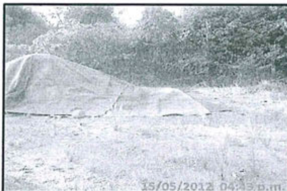
Fotografía 07. Centro de acopio temporal de tierra contaminada con hidrocarburo. No tiene bermas para contener posible migración de hidrocarburo o lixiviado.
