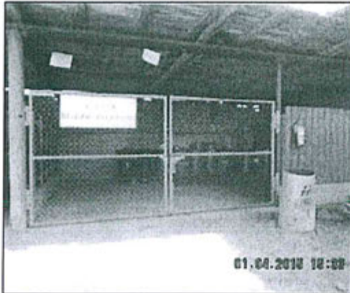
Fotografía N° 1: Almacén Residuos Peligrosos rotulado, con extintor en su exterior y cilindro con arena (1-4-15)
