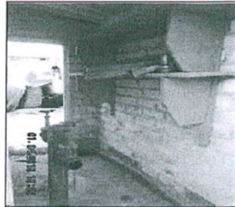
Fotografía N° 2: Hidrante con manga y pitón disponibles dentro del almacén N° 04 y cerca al almacén de residuos peligrosos (1-4-15)
