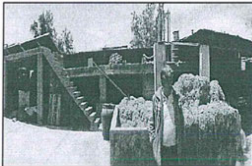
Foto N° 21: vista panorámica del patio de la planta industrial donde se visualiza las pozas de almacenamiento de residuos peligrosos (viruta producto del raspado, polvillo del lijado y los lodos residuales de las pozas de sedimentación) mezclados, nótese que la cantidad de residuos sobrepasa la capacidad de la poza.
