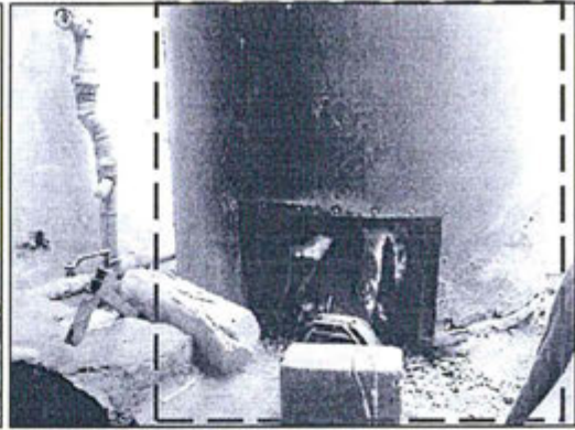
Foto N° 9: Otra vista del segundo caldero en pleno proceso de combustión.
