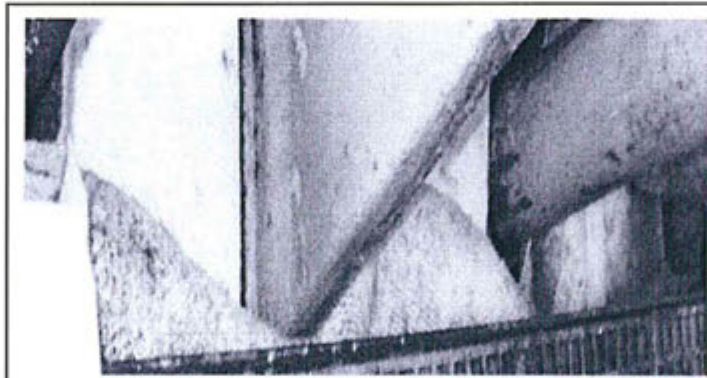
Instalación de materiales antiderrames en ventanas y partes laterales, que evitan caída al mar
