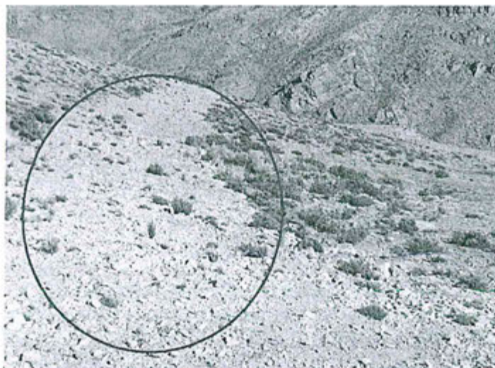
Fotografía N° 7. Viste frontal del acceso secundario-Sector Canahuire
