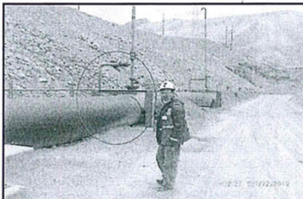
Foto 31: Verificación de la limpieza en la zona de la válvula de aireación en un lado de la tubería línea Norte (Cumplimiento de recomendación N° 8 del 2011).
