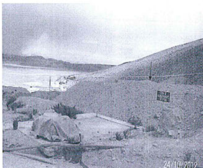
Foto N° 65.- Observación N° 3, Depósito de Topsoil ubicado en la margen izquierda de la vía de acceso al NV 4720. Falta completar cerco perimetral.
