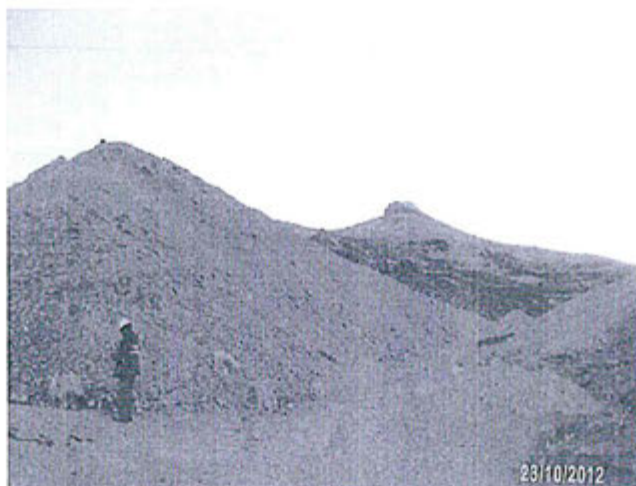
Foto N° 63.- Observación N° 3: Depósito de Topsoil ubicado tanto en la margen derecha de la vía de acceso al NV 4720, falta completar cerco perimetral lado Norte.
