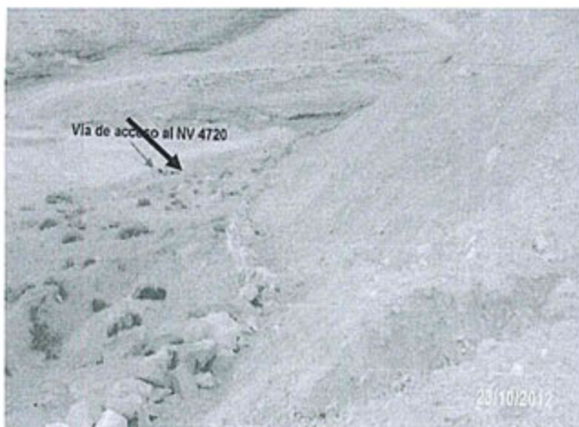
Foto N° 62.- Observación N° 3, Depósito de Topsoil ubicado tanto en el margen derecha de la vía de acceso al NV 4720, falta de mantenimiento.
