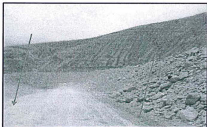
Fotografía N° 4: Vías de acceso dentro de la unidad minera sin cunetas.
