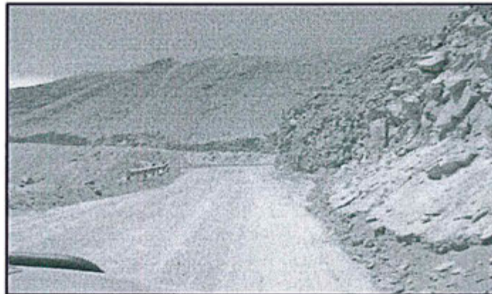
Fotografía N° 3: Vías de acceso a la Unidad Minera sin cunetas.
