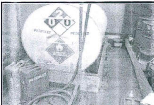
Vista 26. El tanque diesel no cuenta con un adecuado sistema de contención que evite posibles derrames de hidrocarburos.
