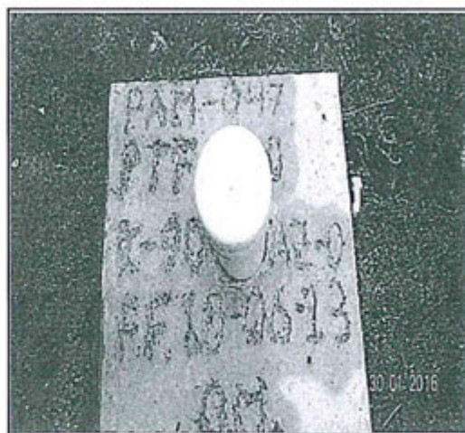
Vistas fotográficas del dado de concreto construido y la tubería insertada al sondaje diamantino PAM-047, ubicado en la Plataforma de Perforación PTF-110
