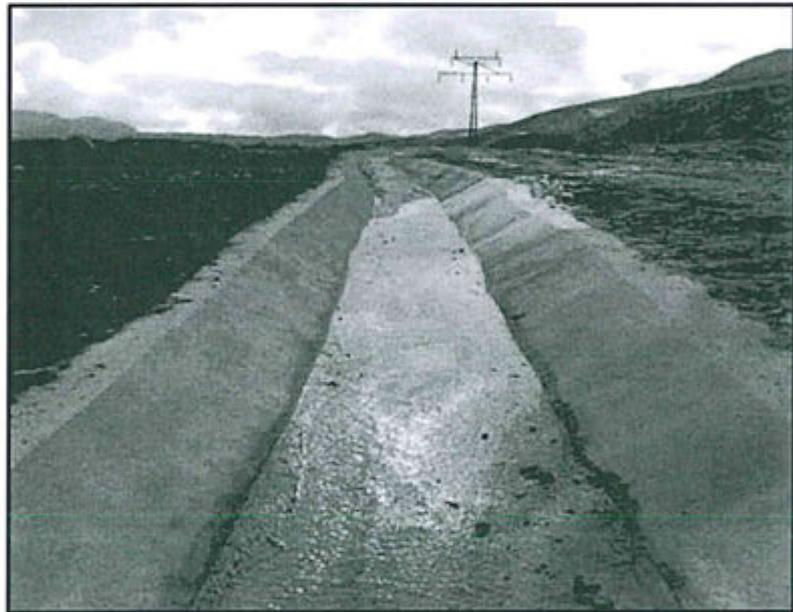
128. Posteriormente, mediante escrito del 15 de febrero del 2016, Volcan adjuntó fotografías que acreditan la implementación de canales de coronación en el depósito de desmonte Huacracocha, conforme se muestra a continuación:
