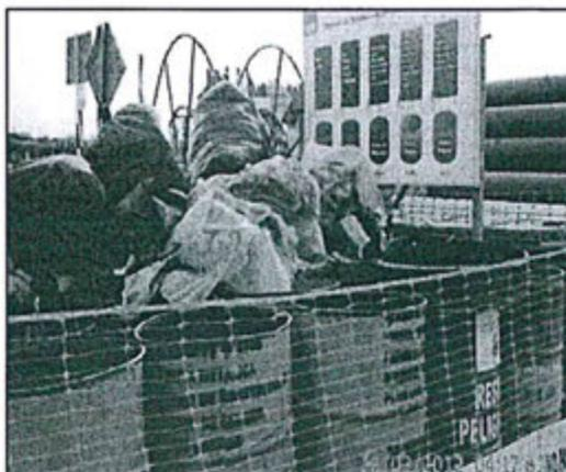
Fotografía 10: Almacén temporal de residuos en City Gate. Recipientes sin tapas y apilamiento inadecuado.
