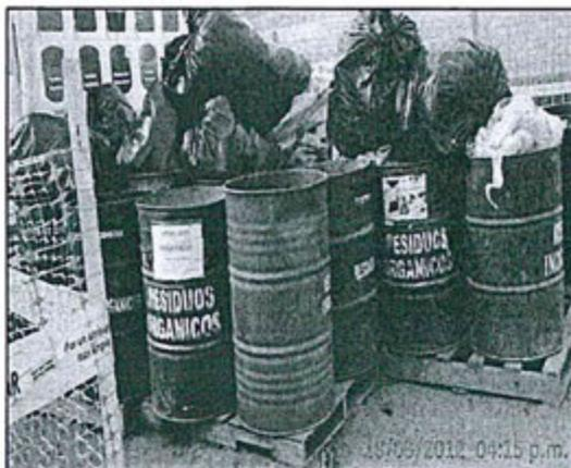
Fotografía 9: Almacén temporal de residuos en City Gate. Residuos exceden los recipientes. Apilamiento inadecuado.
