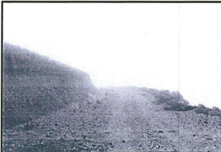
Ubicación del área donde se instaló la poza de lodos de la plataforma de perforación de código BPSL-154
