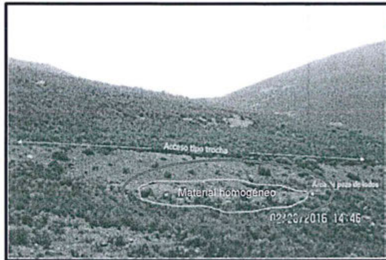
Vista actual de área donde se instaló la poza de lodos de la plataforma de perforación de código BPSL-154
