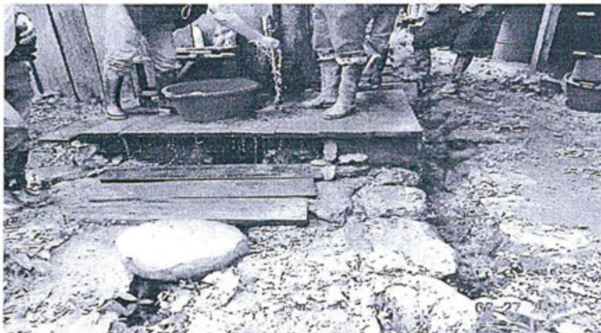
Fotografía 4.- Pileta en la parte trasera del comedor del campamento Cristal, que no cuenta con estructuras apropiadas para la conducción de aguas.
