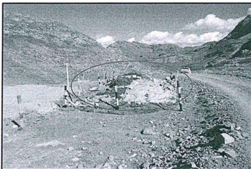
Foto N° 4.- Depósito de suelo orgánico con cubierta de plástico deteriorada. Coordenadas UTM (WGS 84 E: 314 71; N: 8 833 555)
