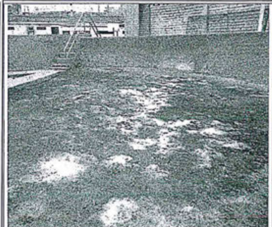
Fotografía N° 2: área estanca de los tanques de Almacenamiento (Zona Baja), muestra suelo NO impermeabilizado, se observa porciones de sal sólida cristalizada, además suelo húmedo, por presencia de napa freática superficial.
