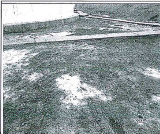
Fotografía N° 1: área estanca de los tanques de Almacenamiento (Zona Baja), muestra suelo NO impermeabilizado, se observa porciones de sal sólida cristalizada, además suelo húmedo, por presencia de napa freática superficial.
