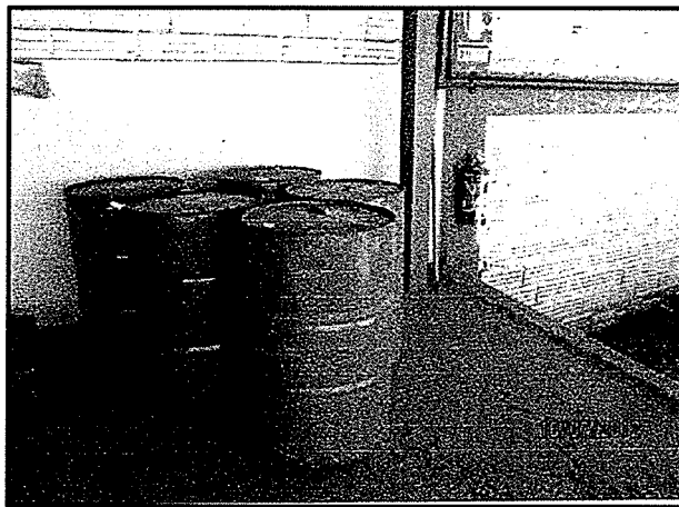
Fotografía N° 2: Almacén de productos químicos (pintura) no cuenta con sistema de doble contención ni impermeabilizado.
