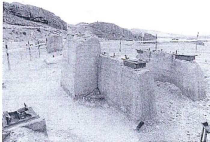
Foto N° 14. Estructuras de cimentación de la antigua planta concentradora en un área de 200 x 100 metros aproximado.
