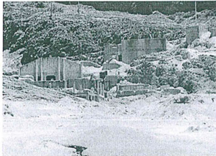
Foto N° 33. Vista de la antigua planta concentradora junto a la relavera
