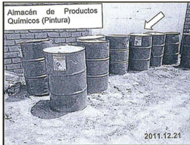
Fotografía N° 4: El almacén de envases de pintura no se encuentra en suelo impermeabilizado y con doble contención.
