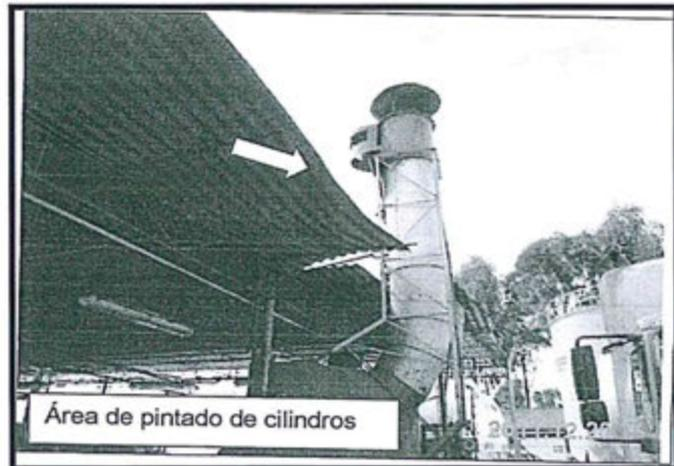
Fotografía N° 6: Emisión de material particulado de pintura por el ducto de la cabina de pintado.
