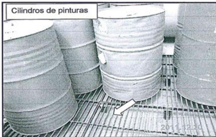
Fotografía N° 4: Los cilindros de pintura son almacenados en rejillas sobre arena, no cuenta con impermeabilización de suelos y sistema de doble contención.
