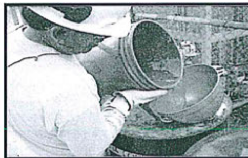
El contenido de los recipientes fue trasvasado en cilindros metálicos. Los cuales fueron debidamente identificados y ubicados en el almacén de residuos peligrosos
