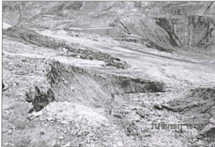
Foto N° 24.- Observación N° 9. Supervisión 2011: Otra vista de las cárcavas provocadas por erosión hidráulica, ubicado en la parte oeste del depósito de desmontes Suro Norte.
