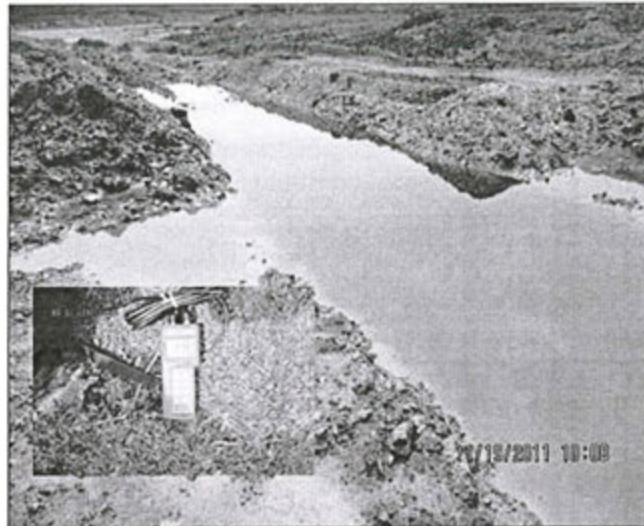
Foto N° 26.- Observación N° 10. Supervisión 2011. Poza con acumulación de aguas ácidas (lectura en campo del potenciómetro, pH 2,70) ubicada en la parte media del depósito de desmontes Suro Sur. Coordenadas UTM WGS-84 E: 823 099; N: 9 116696.
