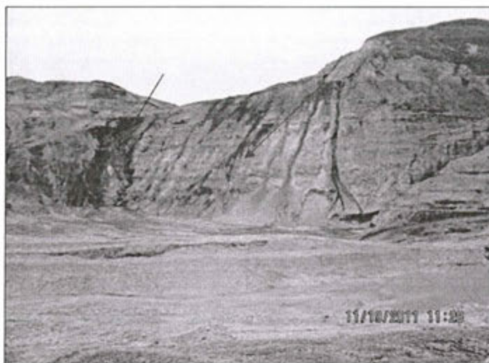
Foto N° 59.- Observación N° 11. Supervisión 2011. Filtraciones de aguas en el tajo Suro Sur.
