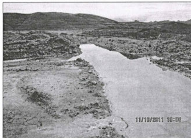
Foto N° 27.- Observación N° 10. Supervisión 2011. Otra vista de la poza de aguas ácidas, ubicada en la parte media del depósito de desmontes Suro Sur. Coordenadas UTM WGS-84 E: 823 099; N: 9 116 696.
