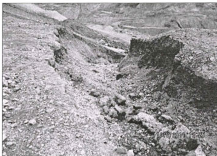
Foto N° 23.- Observación N° 9. Supervisión 2011: Cárcavas provocadas por erosión hidráulica, ubicado en la parte oeste del depósito de desmontes Suro Norte.
