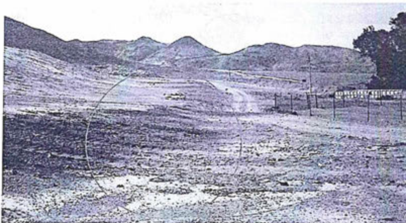
Foto N° 22: Talud de poza N° 3: Los relaves habían invadido un tramo de la carretera, por lo que se dejó la Recomendación N° 3-2011: implementar un muro de contención al pie del talud del depósito de relaves N° 3 para un mejor manejo de la disposición de relaves.
