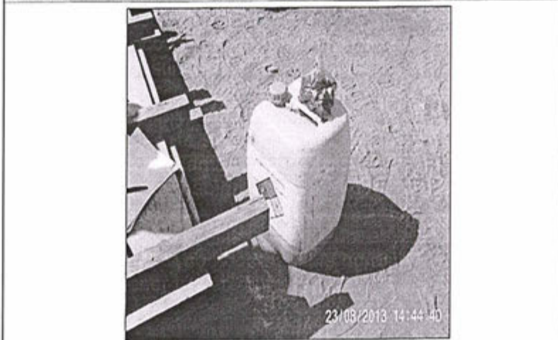
Vista 12. Material peligroso (combustible) ubicado directamente sobre el suelo.
