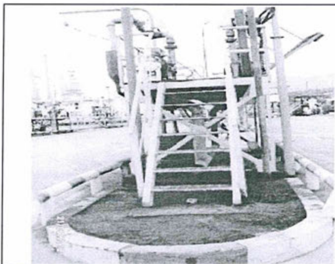
Foto N° 8 Refinería La Pampilla Planta de Ventas- Tierra impregnada con hidrocarburo en un área aproximada de 9 x 2 m, debajo del puente N° 1 contómetro 2.
