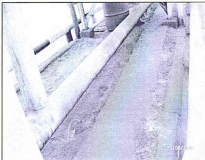
Foto N° 10. Refinería La Pampilla. Planta de Ventas.- Tierra impregnada con hidrocarburo en un área aproximada 13 x 2 m, debajo del puente N° 2 contómetro 46 diésel y contómetro 10 diésel.
