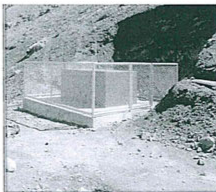
Foto N°9: Plataforma de monitoreo de calidad de aire culminada con cartel de identificación y pintado correspondiente, Punto de monitoreo E-10: Desmontera N°2 San Cristóbal.
