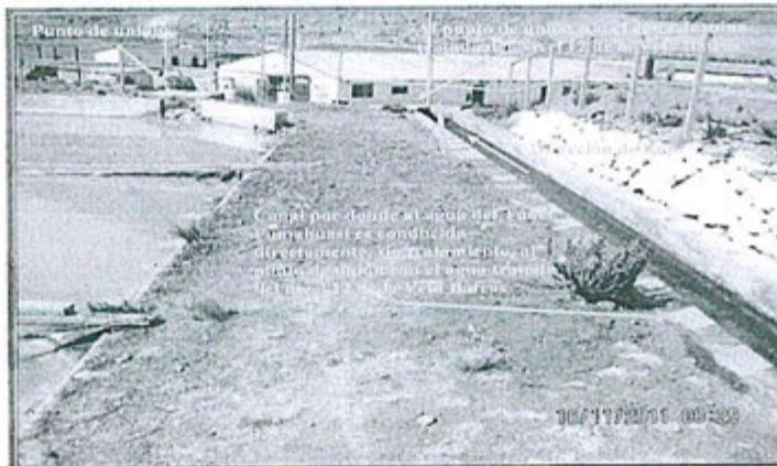
FOTOGRAFIA N° 152.- Descarga de agua de mina del Nivel 12 Pumahuasi: La descarga del agua de mina del Nivel 12 Pumahuasi es conducida por este canal, directamente al punto de unión con el agua tratada del Nivel 12 de la Veta Bateas.
