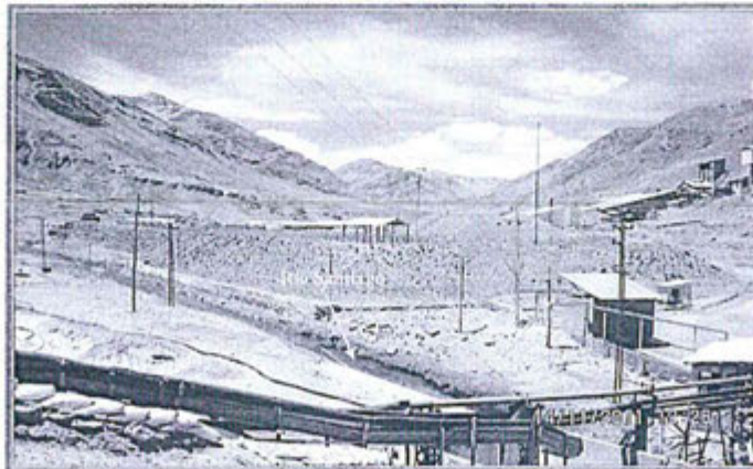
FOTOGRAFIA N° 184.- Evaluación de peligros y riesgos del sistema de conducción de relaves: La tubería que sale de la caseta de bombeo y cruza el río Santiago, no cuenta con canaleta de contingencia, en caso de rotura y/o despalmado de tubería, el relave caería directamente al cauce del río Santiago. Observación N° 03.
