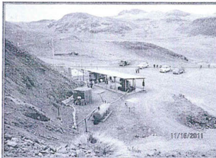
FOTOGRAFIA N° 305.- Vista fotográfica del Nv. 7 Santa Catalina, usado como servicios para ventilación e ingreso de la tubería de aire comprimido.
