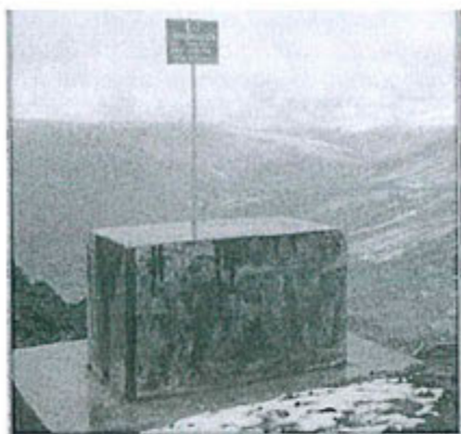
Foto N°7: Plataforma de monitoreo de calidad de aire acabado de obra civil y con su cartel de identificación del punto E-7: Santa Catalina / Barlovento
