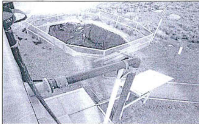
Fotografía N° 37. Poza de secado de lodos de las Plantas melizas de tratamiento de aguas residuales domésticas de la unidad minera San Cristóbal.
