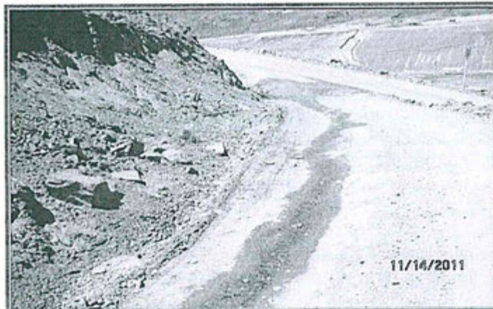
FOTOGRAFÍA N° 36.- Observación N° 01: En el área de la tolva de gruesos de la planta concentradora, se verificó que las cunetas de las carreteras en un tramo de 100 m estaban colmatadas. El agua discurre por la carretera.
