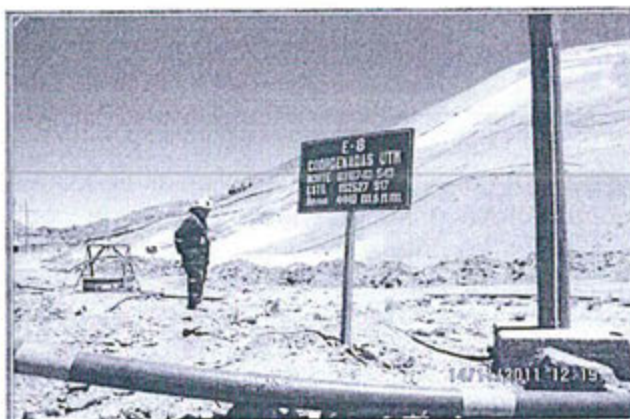
FOTOGRAFIA N° 172.- Depósito de Relaves N° 2, Veta San Cristóbal: Vista de la estación de monitoreo E-8 fluente de aguas residuales provenientes del rebose depósito de relaves.
