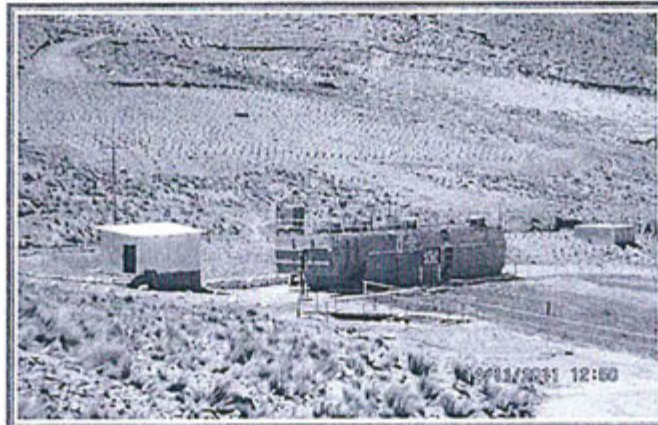
FOTOGRAFIA N° 71.- Observación N° 12: En la planta de tratamiento de aguas residuales domésticas se verificó la inexistencia de estructuras de lecho de secado para la disposición de lodos antes de la disposición final por una EPS-RS, según compromiso asumido en la R.D. N° 173-2011-MEM/AAM e Informe N° 567-2011/MEM-AAM/MES/RBG/YBC/PRR/CMC/ACHM (Observación N° 38, páginas 27 y 28).
