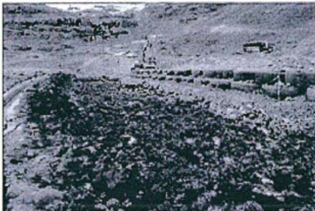
Foto 7-5: Etapa Final. Depósito de desmote E-1. Para asegurar la estabilidad del talud, se construyó un muro de pie de talud, con material reciclable. Para ello fue necesario, realizar un corte del talud y retirar material de desmote de mina. Con ello, se aseguró la estabilidad del Talud.
