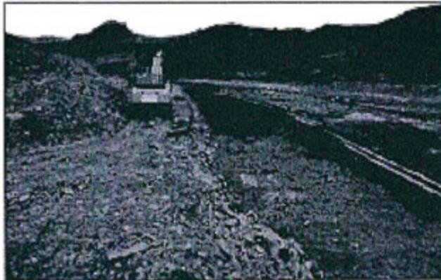
Foto 7-4: Proceso. Depósito de desmote E-1. El relleno de topsoil, se recubre con material orgánico, como una etapa final del proceso. También se construye el muro de pie de talud con material reciclable (llantas pesadas).
