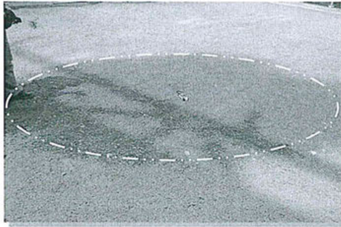
Foto 11: Derrame de hidrocarburos en un área de 3 x4 metros, frente a la sala de distribución eléctrica 30/4.16KV. Sección 91-20.
