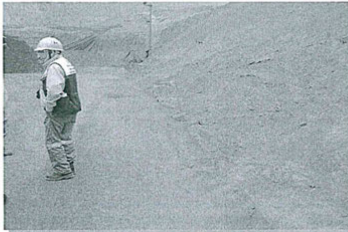
Foto 05: Talud de la plataforma sin recubrimiento y berma deteriorada en la cancha de descarga de concentrado.
