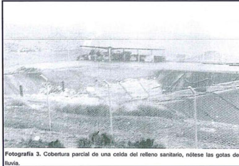
Fotografía 3. Cobertura parcial de una celda del relleno sanitario, nótese las gotas de lluvia.
