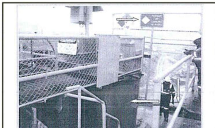
Fotografía N° 9: La poza de contingencia del tanque de preparación de cianuro en Planta Concentradora Amistad cuenta con un sumidero que descarga la solución hacia el medio natural impactándolo directamente. Recomendación N° 4. UM Morococha, 2011.
