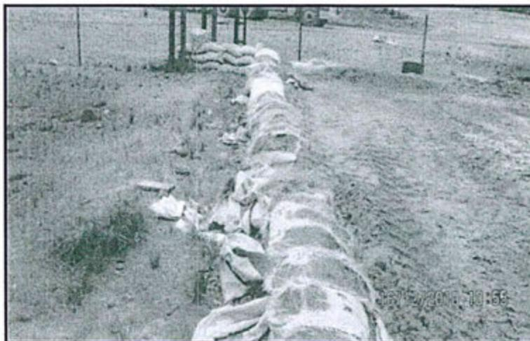
"Fotografía N° 10: Cerco perimétrico del área de cicloneo con bolsas de polietileno roto rellenos con relave."
