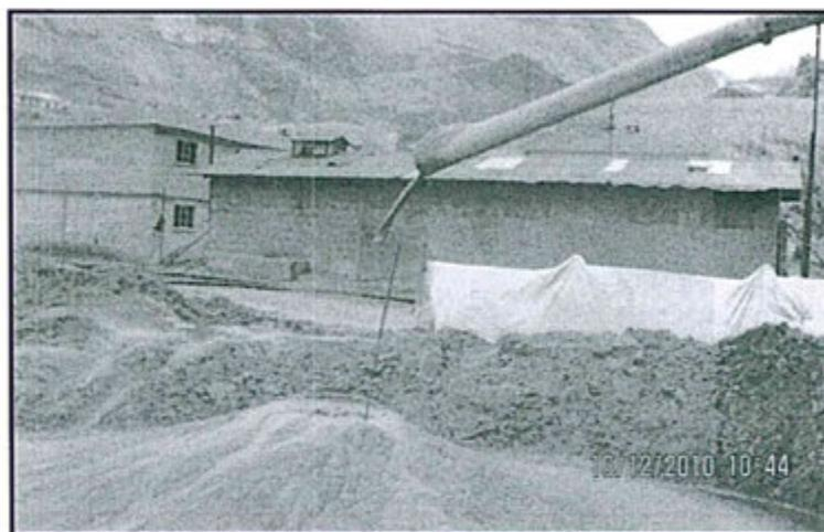
"Fotografía N° 11: Cerco deficiente del área de cicloneo y potencial de derrame hacia el exterior de suelo natural."
