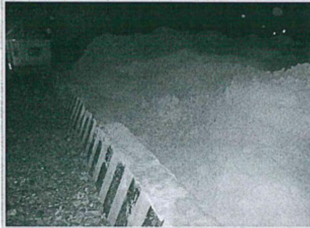
Fotografía N° 31: Deposito de relaves overflow para relleno hidráulico, se observa que los muros de contención han sido sobrepasados por la acumulación de relave, Recomendación N° 12, UM Morococha, 2011.
