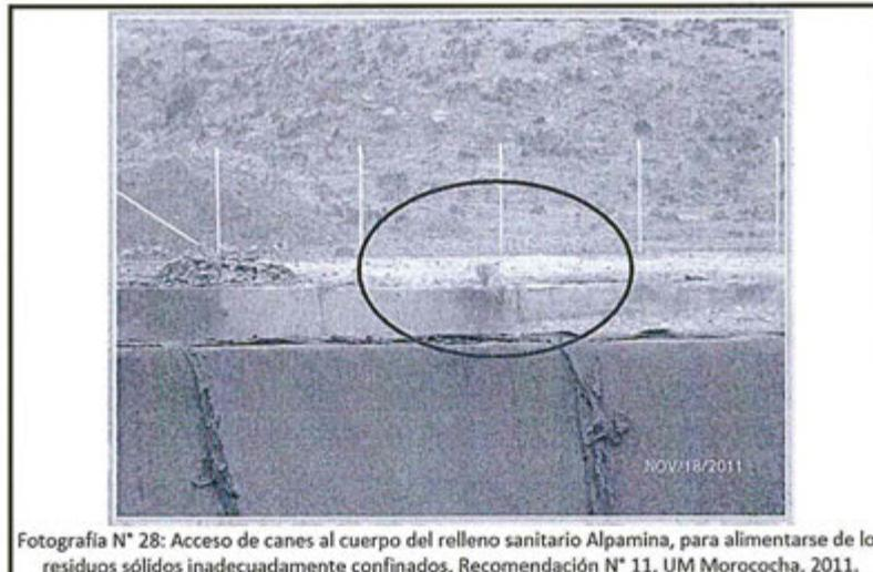
Fotografía N° 28: Acceso de canes al cuerpo del relleno sanitario Alpamina, para alimentarse de los residuos sólidos inadecuadamente confinados, Recomendación N° 11, UM Morococha, 2011.
