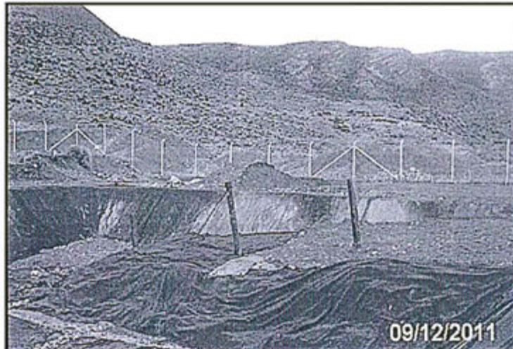
"Fotografía N° 10: Se ha completado la protección de la base del cerco perimétrico del relleno sanitario con un muro."
