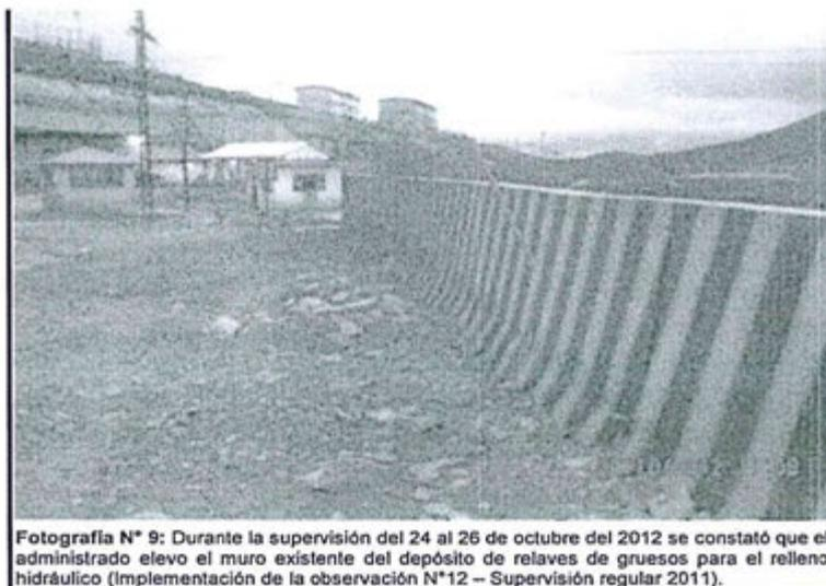
Fotografía N° 9: Durante la supervisión del 24 al 26 de octubre del 2012 se constató que el administrado elevó el muro existente del depósito de relaves de gruesos para el relleno hidráulico (Implementación de la observación N°12 – Supervisión regular 2011).
