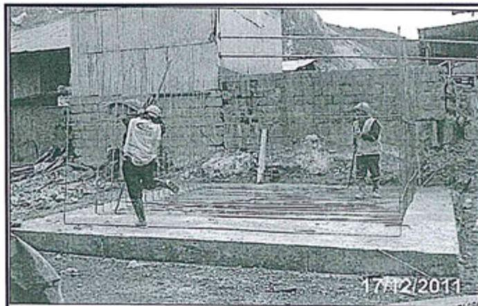
Fotografía 07. Véase el proceso constructivo del nuevo tanque de preparación de Cianuro.
