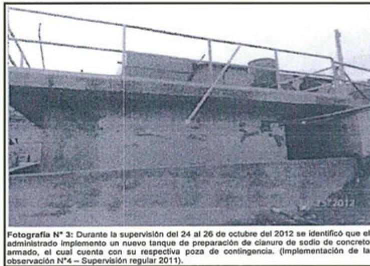
Fotografía N° 3: Durante la supervisión del 24 al 26 de octubre del 2012 se identificó que el administrado implemento un nuevo tanque de preparación de cianuro de sodio de concreto armado, el cual cuenta con su respectiva poza de contingencia. (Implementación de la observación N°4 – Supervisión regular 2011).
