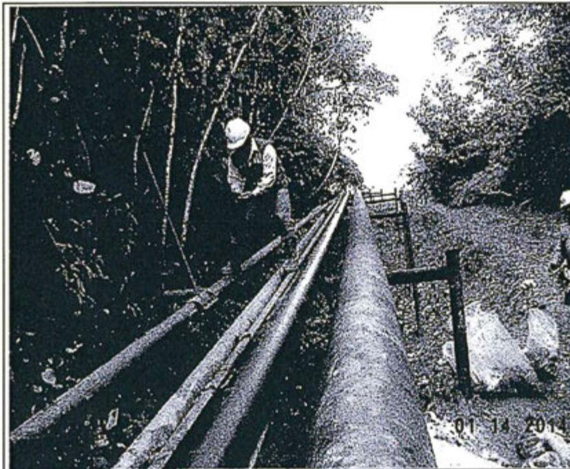
Fotografía N° 2.- El supervisor del OEFA en plena constatación de la tubería averiada y de la colocación de la grapa metálica con la finalidad de evitar mayores derrames.
