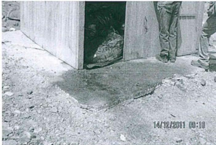
Foto N° 9.- OBSERVACION No 03-2011. El titular minero debe completar un sistema de mitigación, para evitar el derrame de lixiviados e impacto al suelo.
