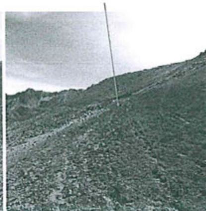
Vía de acceso cerrada
