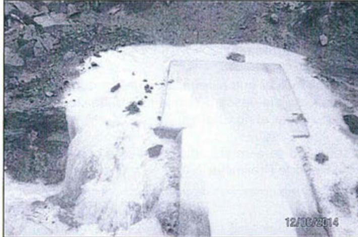
FOTOGRAFÍA N° 6.- Rebose de las aguas provenientes del depósito de relaves Santa Catalina en la caja de conexión con las tuberías. Nótese el flujo de agua que ingresa a la quebrada Santa Catalina.
