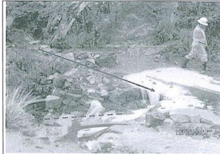
FOTOGRAFÍA N° 5.- Rebose del canal de conducción de subdrenajes del depósito de relaves Santa Catalina en la caja de conexión con las tuberías. Nótese el flujo del subdrenaje que ingresa a la quebrada Santa Catalina.
