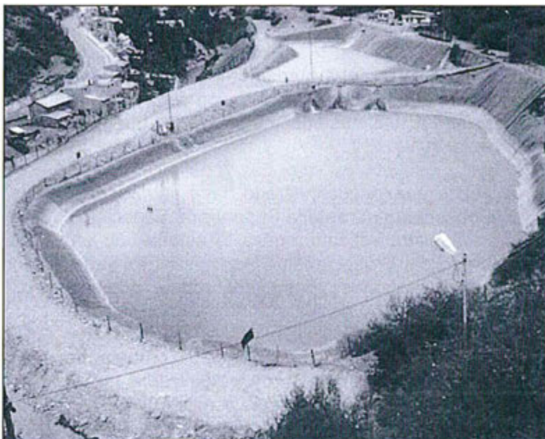
Fotografía N° 2: Vista actual de la poza de sedimentación N° 1. Nivel – 450, La Quinua.
