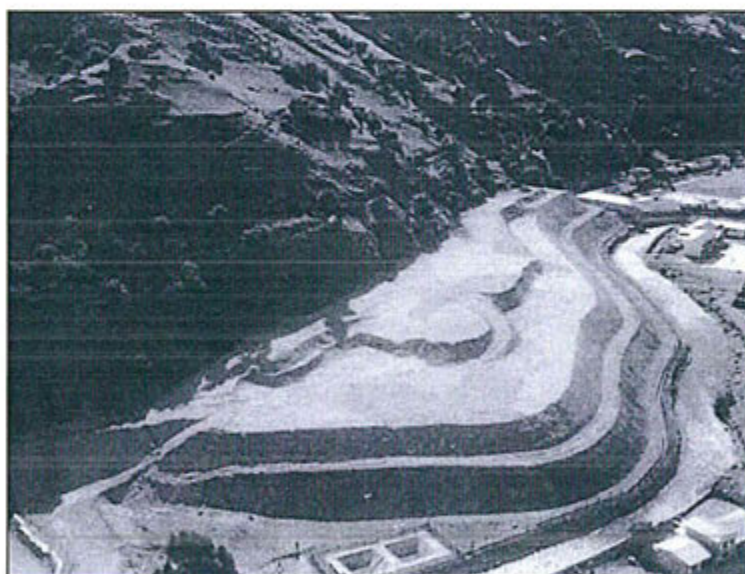
Fotografía N° 5 Vista actual de la desmontera.
