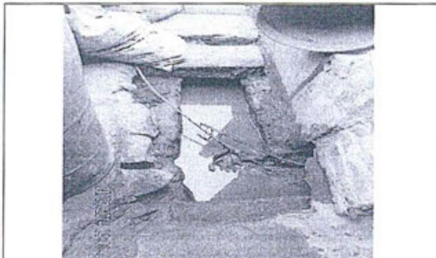
Foto N° 11: Se observa las aguas residuales generadas en los procesos de la planta Uchumayo conducidas sin tratamiento previo para ser descargadas al canal de tierra.
