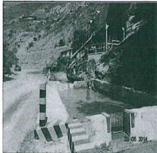
Foto N°2: Mejora de pared lateral de poza de sedimentación N°2 y cámara de rejas
