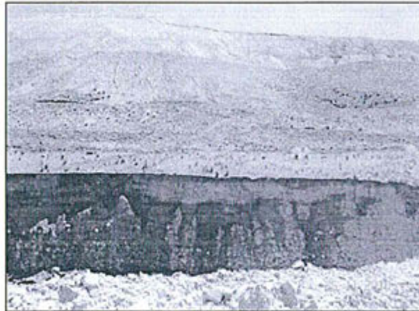
Foto 2.6 Obs. 4. El botadero de desmonte Suro Norte, en las cotas más bajas cercanas con la línea del río Suro no cuenta con sistema de subdrenaje y cuneta perimetral o canal de derivación para captar las aguas de escorrentía.
