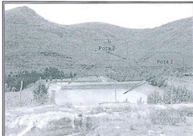
Fotografía N° 24. Vista de las dos pozas de impermeabilización para captar y sedimentar el subdrenaje del botadero Suro Norte.
