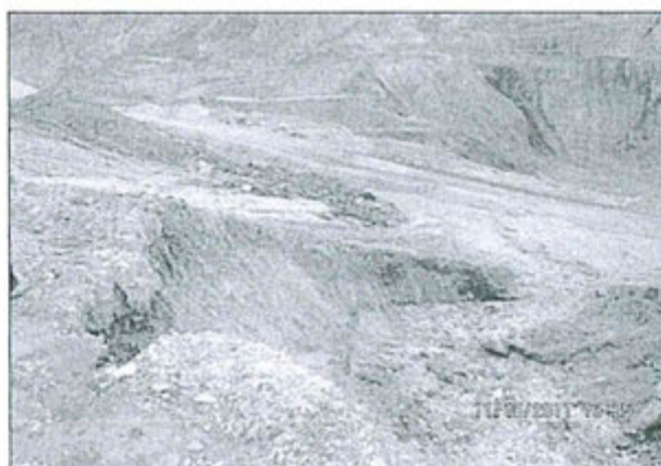
Foto N° 24.- Observación N° 9. Supervisión 2011: Otra vista de las cárcavas provocadas por erosión hidráulica, ubicado en la parte oeste del depósito de desmontes Suro Norte
