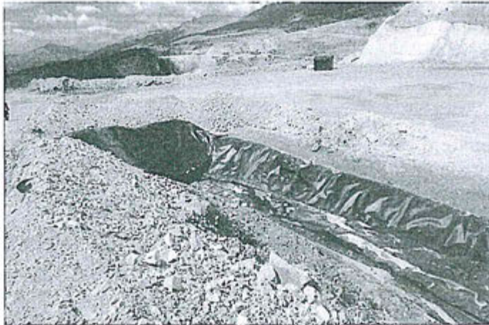
OTRA VISTA FOTOGRÁFICA DEL CANAL DE CORONACION QUE DERIVA LAS AGUAS DE LLUVIA HACIA LA QUEBRADA TRES CRUCES
