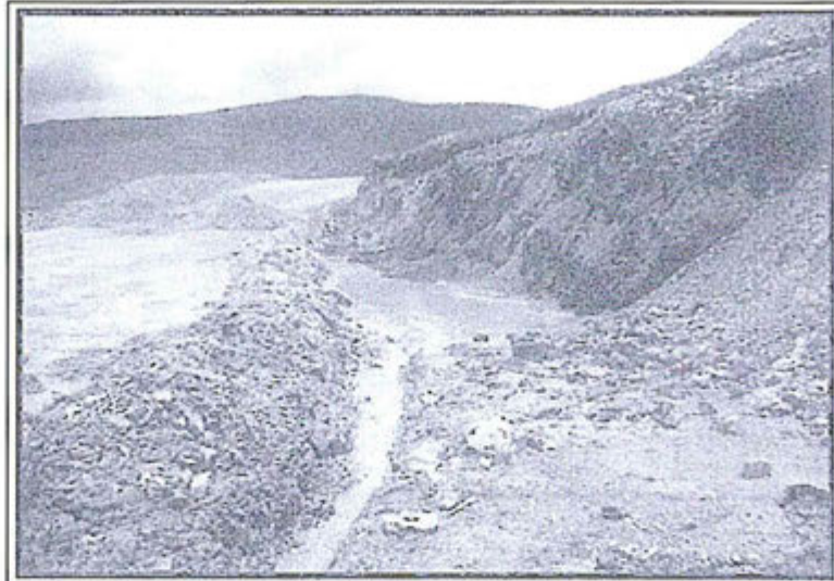
Las aguas de la poza de decantación fueron evacuadas quedando la poza cero de aguas almacenadas ya que solo era acumulación de aguas de escorrentía.
