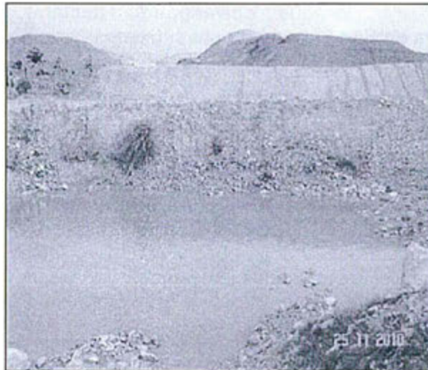
Foto 2.19 Obs.12. La poza de lixiviados del relleno sanitario, se encuentra en depresión del terreno, la cual actualmente está sumergida con agua de precipitaciones.
