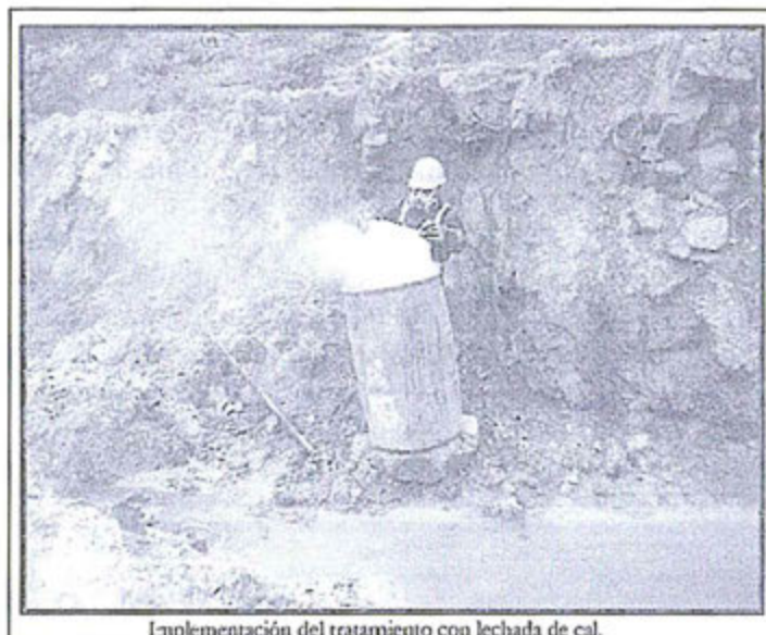
Implementación del tratamiento con lechada de cal.
