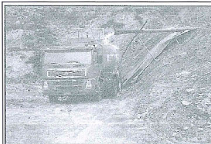
Las aguas acumuladas en la poza fueron evacuadas con una sistema hacia una poza de tratamiento oficial que es el punto de control SD-F5.
