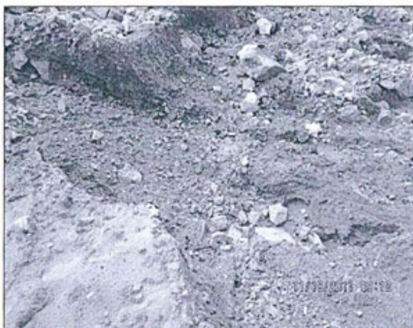
Fotografía N° 7: Observación N° 2. Supervisión 2011. Otra vista de la cárcava, ubicado al costado de la poza de sedimentación que capta las aguas del canal de coronación de los PAD de lixiviación (coordenadas UTM WGS-84 E: 820 799 N: 9116510). La poza de sedimentación no se observa porque se encuentra en la parte superior izquierda la vista fotográfica (en la foto N° 5 se observa la poza de sedimentación).
