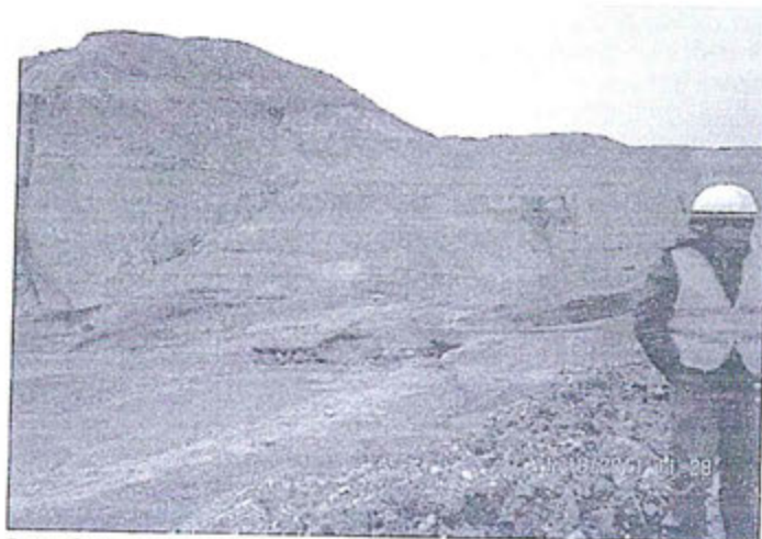
Foto N° 60.- Poza de sedimentación de aguas de mina en el tajo Suro Sur.
