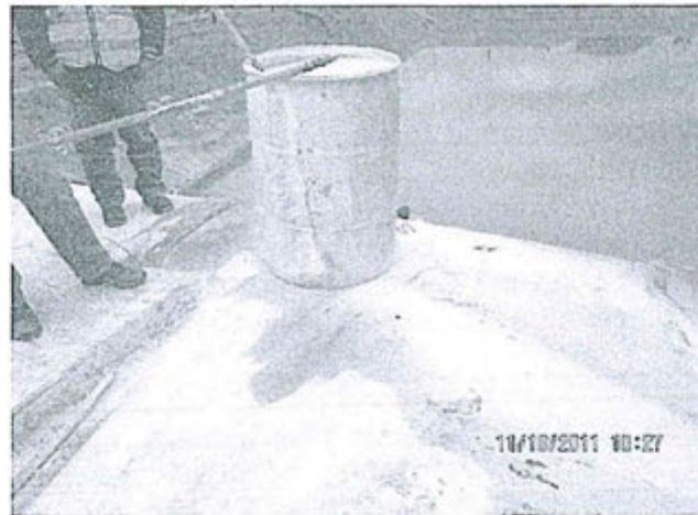
Foto N° 64.- Se aprecia que la preparación de la lechada de cal es en forma manual.
