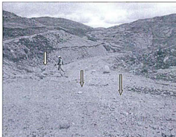
Foto N° 19.- Observación N° 7. Supervisión 2011. Se observó erosión hidráulica (flechas en rojo), del canal de coronación del tajo Suro Norte (flecha en blanco), que se encuentra interrumpido en esta zona.
