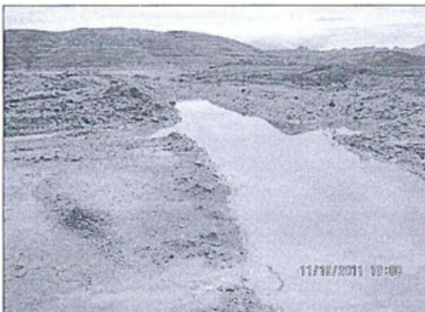
Foto N° 27.- Observación N° 10. Supervisión 2011. Otra vista de la poza de aguas ácidas, ubicada en la parte media del depósito de desmontes Suro Sur. Coordenadas UTM WGS-84 E: 823 099; N: 9 116696.
