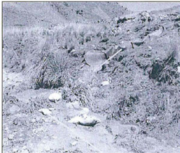
Foto 2.4 Obs. 2 Punto de descarga del efluente SD-SN (Sub dren-Suro Norte), cuyas aguas con sedimentos de coloración rojiza, que discurre a través de la Qda. Paloquian.
