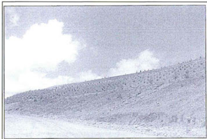
Fotografía N° 05. Vista del botadero Suro Norte, donde se encontraron zonas menores con erosiones contiguo a la vía de acceso por el lado oeste.
