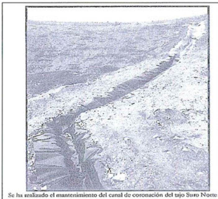
Se ha realizado el mantenimiento del canal de coronación del tajo Suro Norte
