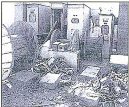
Fotografía N° 30: Almacenamiento de residuos sólidos sin clasificar y sin rotulo de identificación.
