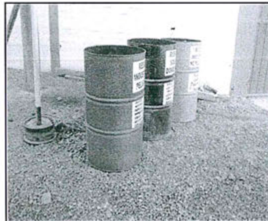
Fotografía N° 14: Contenedores sobre piso sin impermeabilizar (tierra) y sin sistema de drenaje.
