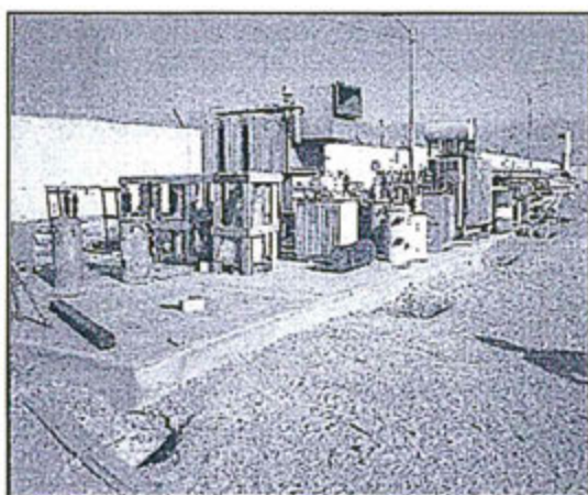
Fotografía N° 25: Almacén temporal de residuos sólidos peligrosos de la SET Ilo sin cerco, sin un sistema de drenaje, sin señalización que indique la peligrosidad de los residuos y sin un sistema contra incendios.
