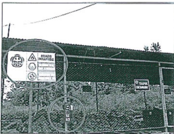
Fotografía N° 2: Almacén Temporal de Residuos Peligrosos con rótulos de identificación de los residuos peligrosos.
