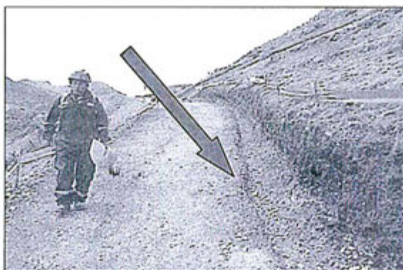
Cuneta en accesos hacia la plataforma DDH-LY-07
