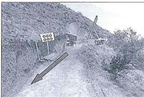
Cuneta en accesos hacia la plataforma DDH-LY-07
