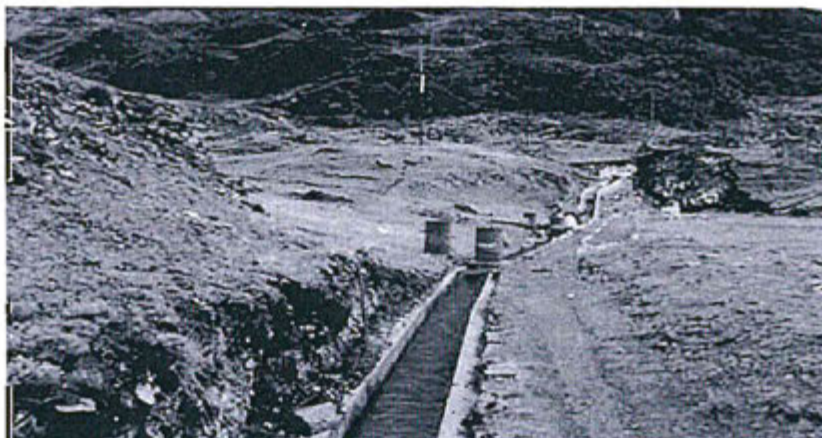
Adición de floculantes y cal en la corriente de agua efluentes para la precipitación solidos metálicos y partículas
