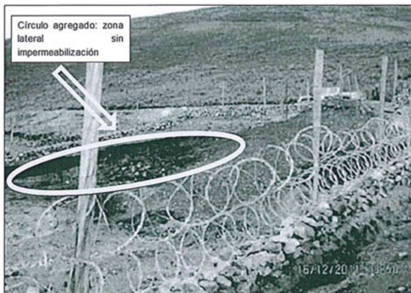
FOTOGRAFÍA N° 192.- Trinchera sanitaria: Se aprecia el área de disposición final de los residuos sólidos domésticos. No se observa impermeabilización, no cuenta con chimeneas para el control de gases y no hay sistema de colección de lixiviados.
