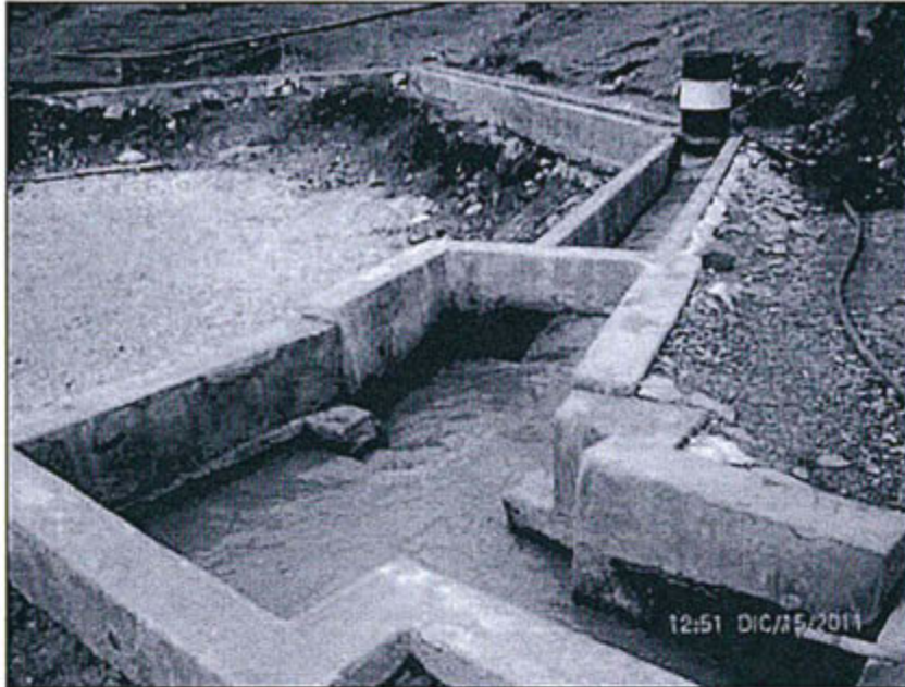
FOTOGRAFÍA N° 142.- Depósito de desmonte Nv. 130 Haswuz y Nv. 185, Canal de coronación. En la vista fotográfica, el canal de conducción del agua de escorrentía superficial del depósito de desmonte Nv. 130 Haswuz y Nv. 185 a la poza de tratamiento de agua de mina del nivel 105.
