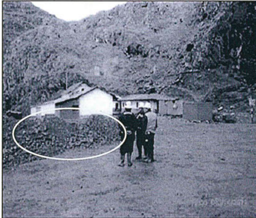
Fotografía N° 46.- Recomendación 4, depósito de mineral cerca a la vía de acceso principal – túnel Gordillo: El depósito de mineral frente al túnel Gordillo continúa sin cerco perimétrico, al costado de un campamento desocupado de la población de Vinchos.
