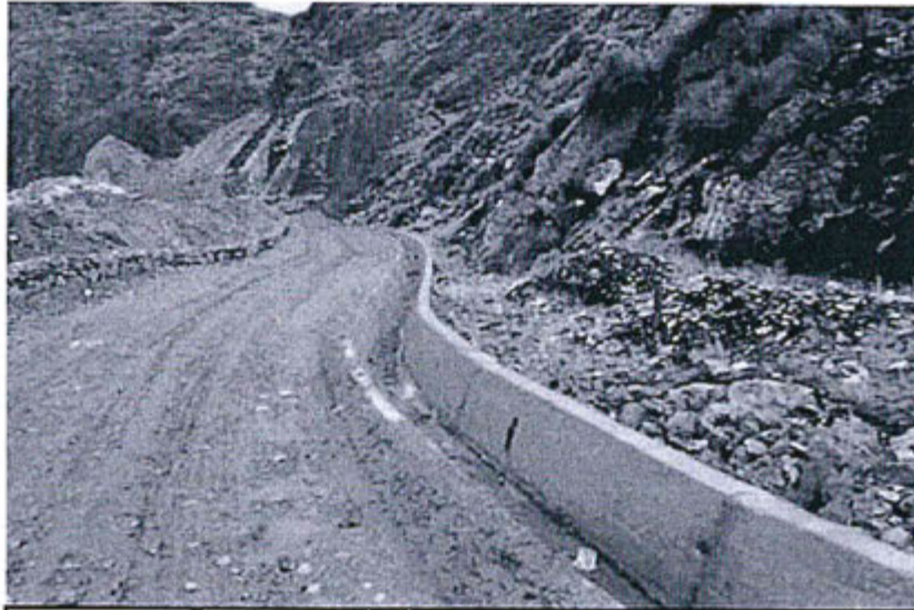
Medio tramo de la cuneta de concreto del Nivel 130
