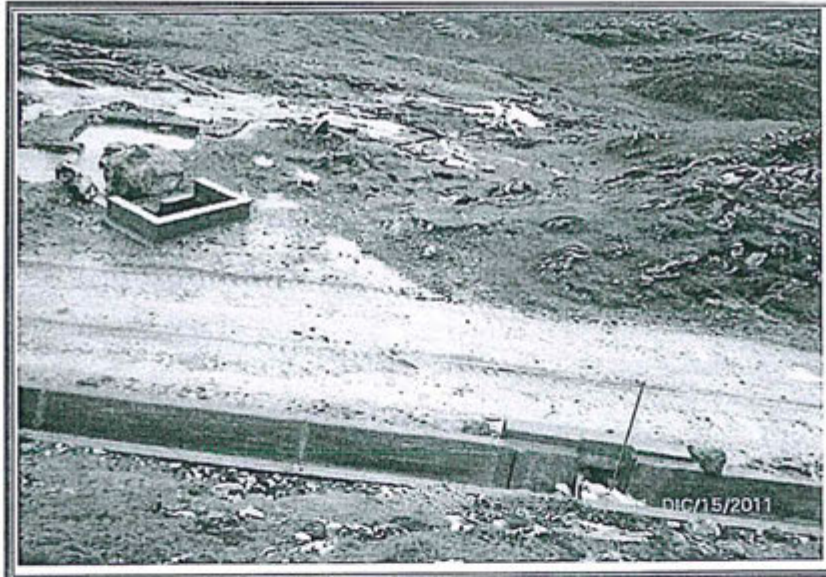
FOTOGRAFÍA N° 71- Observación N° 19: Vista fotográfica de la alcantarilla por donde es desviado al curso natural de agua, el efluente de mina del Nv. 130 Haswuz (paralizado).
