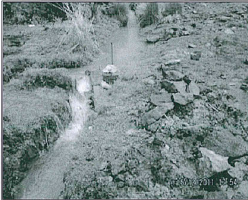
FOTOGRAFÍA N° 81.- Observación 24: Se constató que el titular minero realizó la disposición inadecuada de lodos sobre el suelo natural, del canal que conduce las aguas de la segunda poza de sedimentación ubicada a espaldas de oficinas generales.
