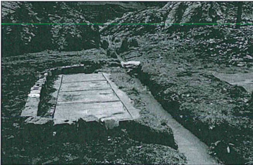
Se evidencia la limpieza de lodos costado del canal externo de la trampa de aceite espalda de oficinas Vinchos.
