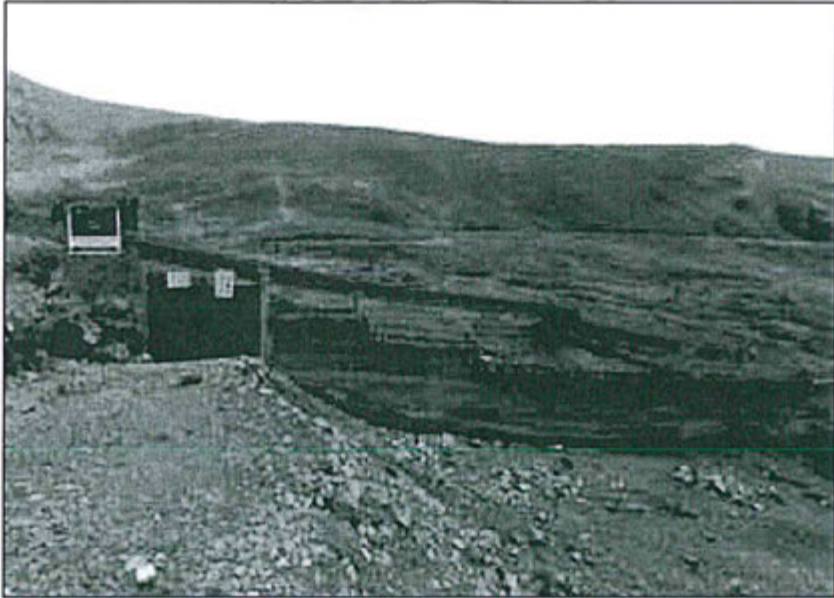
Relleno sanitario - E.E. VINCHOS Ltda. S.A.C.
