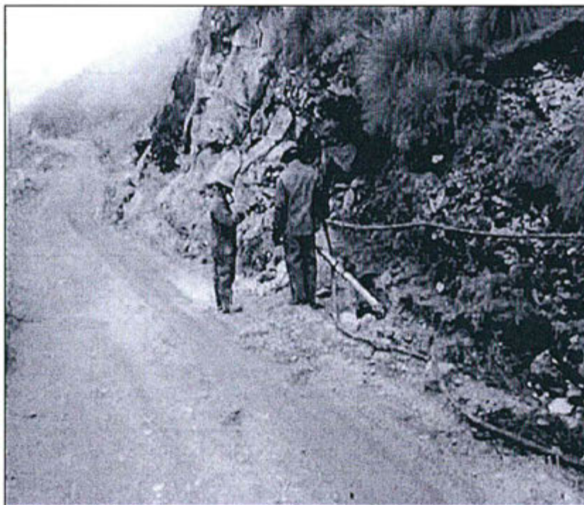
FOTOGRAFÍA N° 53.- Recomendación N° 6, Vía principal Salida Túnel gordillo – Garita Nv. 185: Perforación de taladros para completar la construcción de la cuneta en el tramo faltante.
