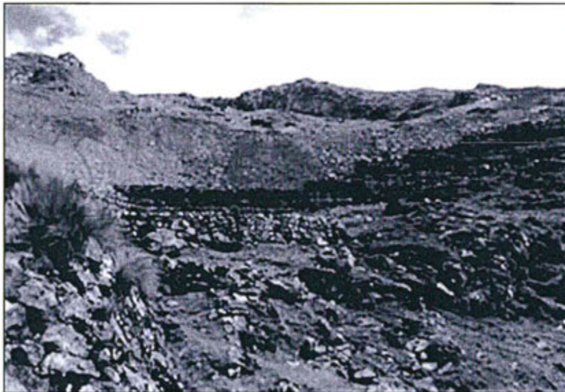
Evacuación de rocas en el punto de acopio de rocas en la desmontera Nv. 130
