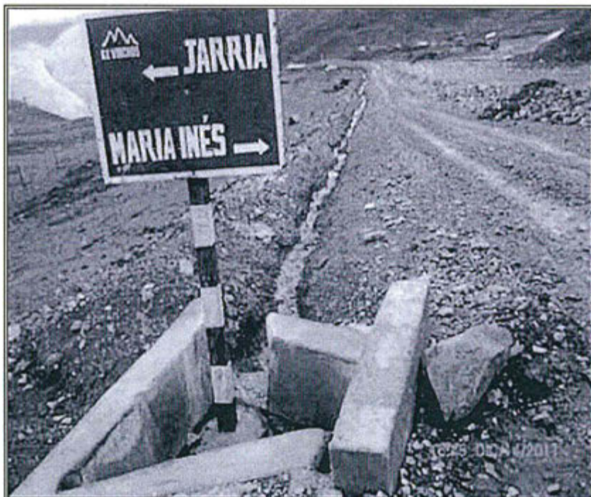
FOTOGRAFÍA N° 19.- Recomendación N° 4. Colección de agua de la cancha de mineral (stock pile): El agua del canal de colección, sigue su curso aguas abajo y es descargado al cauce natural. No está empalmada al sistema de tratamiento de agua de mina.
