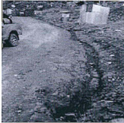
Cuneta para transporte de la corriente de los efluentes de la bocamina (...).
