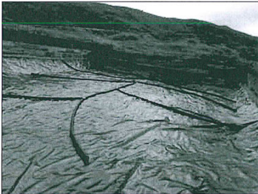
Habilitación de tuberías para la captación de aguas de lixiviación de los residuos sólidos (domésticos)
