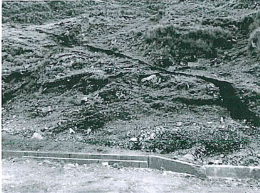
Canal de coronación con la cuneta concreto salida de la Bocamina Nivel 130
