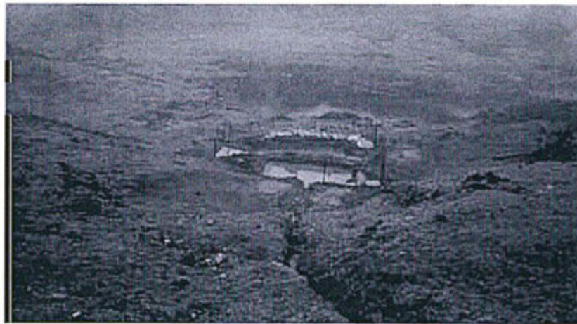
Pozas de lodos para la sedimentación de sólidos y vertimiento de agua hacia la laguna de Mancancoto.
