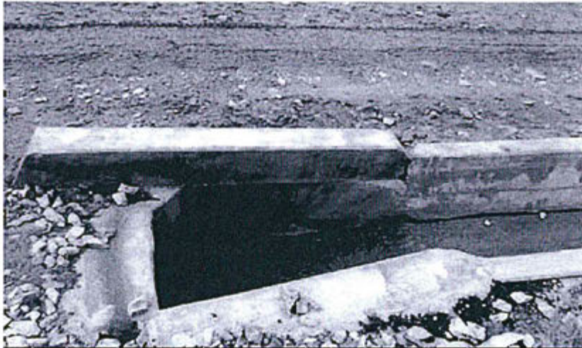
Desvió de los efluentes hacia la planta de sedimentación de lodos
