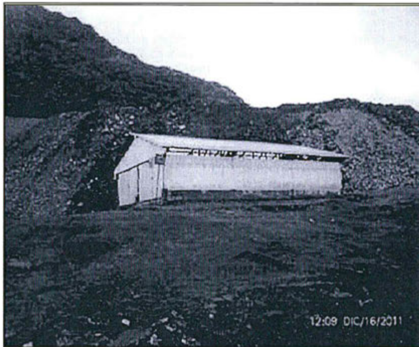
FOTOGRAFÍA N° 25.- Recomendación N° 9. La nueva ubicación de la cancha de volatilización es al costado del depósito de desmonte del Nv. 185, en las coordenadas WGS 84: 8845023N 360810E y 4187 msnm.
