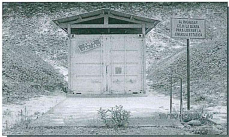
Foto 4: Container como polvorín de almacenamiento de Anfo, obsérvese la falta de canal de derivación de las aguas de escorrentía.
