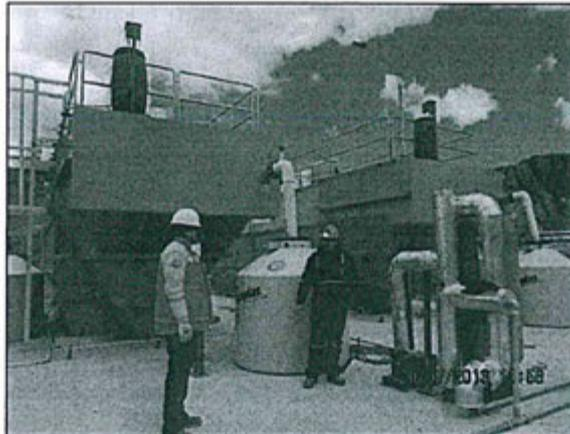
FOTOGRAFÍA N° 160.- Nueva planta de tratamiento de aguas residuales domésticas del campamento El Golf (compuesto por dos sistemas modulares de lodos activados y tratamiento terciario), ubicado con coordenadas UTM datum WGS 84: 8 718 168 N, 377 728 E y 4 391 msnm.
