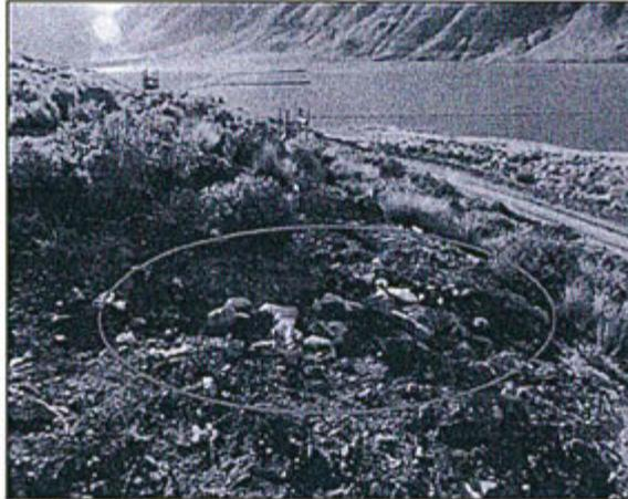
FOTOGRAFIA N° 18.- Se observó la existencia de materiales expuestos tales como: botellas de plástico, tapas, bolsas; sobre las celdas remediadas de disposición final de residuos sólidos, en el relleno sanitario del proyecto PAMA N° 05.
