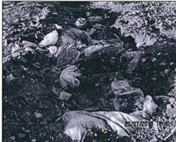
INFORME N° 19.- Se observó la existencia de materiales expuestos tales como: botellas de plástico, tapas, bolsas; sobre las celdas remediadas de disposición final de residuos sólidos, en el relleno sanitario del proyecto PAMA N° 05. Ubicación: coordenadas UTM datum WGS 84: 8 717 480 N, 378 847 E y 4411 msnm.
