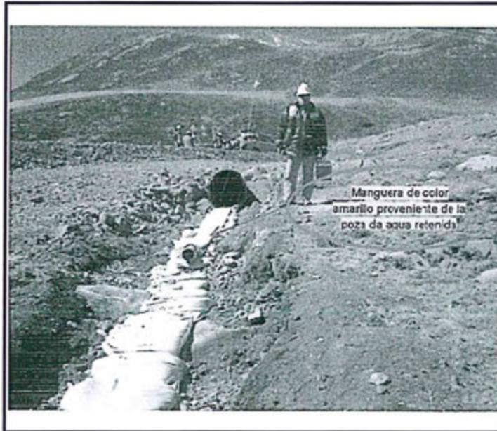
**Fotografía N° 20:** Tubería de drenaje de aguas provenientes del bombeo de agua de la Poza de Agua Retenida hacia la quebrada Rumichaca.
